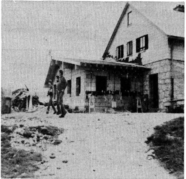
Richtfest auf der Hochries: Der Anbau ist nun bis zum Rohbau gediehen.
