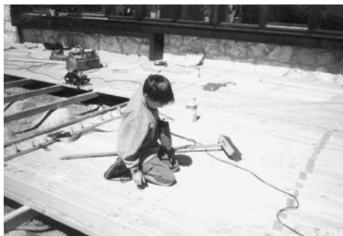
Der Bau der Terrasse nimmt Gestalt an
