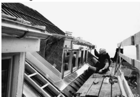
Arbeiten am Dach
