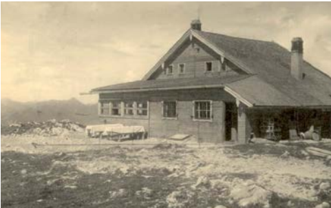
1934 entstand die neue Hochrieshütte
