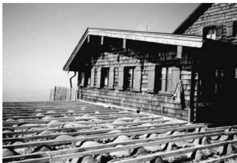
Der Untergrund der Hochriesterrasse
